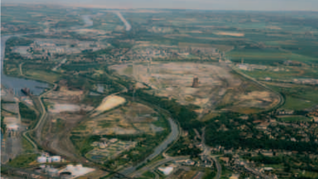
1996 : Le site vierge. Au centre trône le grand réfrigérant et la halle.
